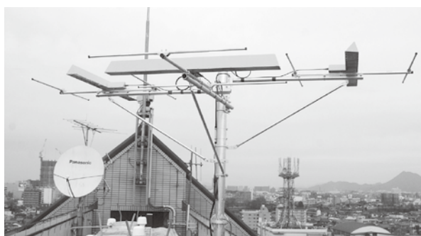
コミュニティFM 防雪型3素子3方向設置
